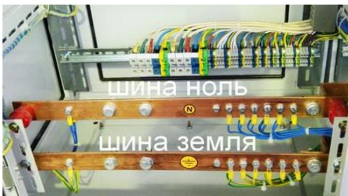
Шина на изоляторах – это специальная деталь, которая применяется при выравнивании потенциалов в частных домах и промышленных помещениях.
