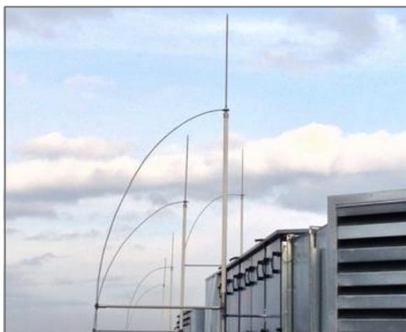
Изолированная молниеприёмная мачта 11 000 мм. выпускается из алюминия, оцинкованной, нержавеющей и окрашенной стали, с порошковой окраской в стандартные цвета кровельных материалов.
