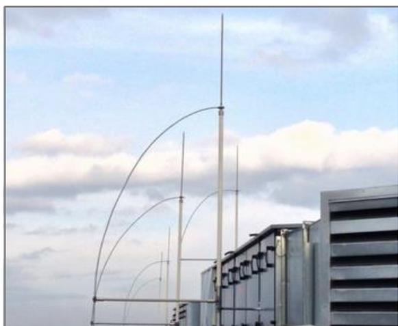
Изолированная молниеприёмная мачта 4 500 мм. выпускается из алюминия, оцинкованной, нержавеющей и окрашенной стали, с порошковой окраской в стандартные цвета кровельных материалов.
